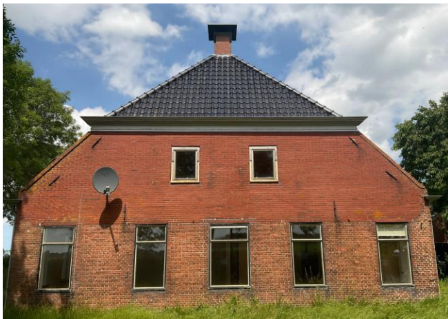
Afb.2: Voorbeeld gemaakte foto recht voor de gevel
