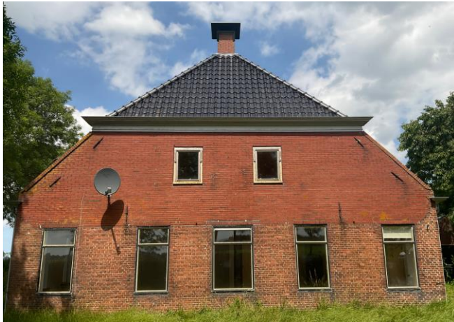
Afb.2: Voorbeeld gemaakte foto recht voor de gevel
