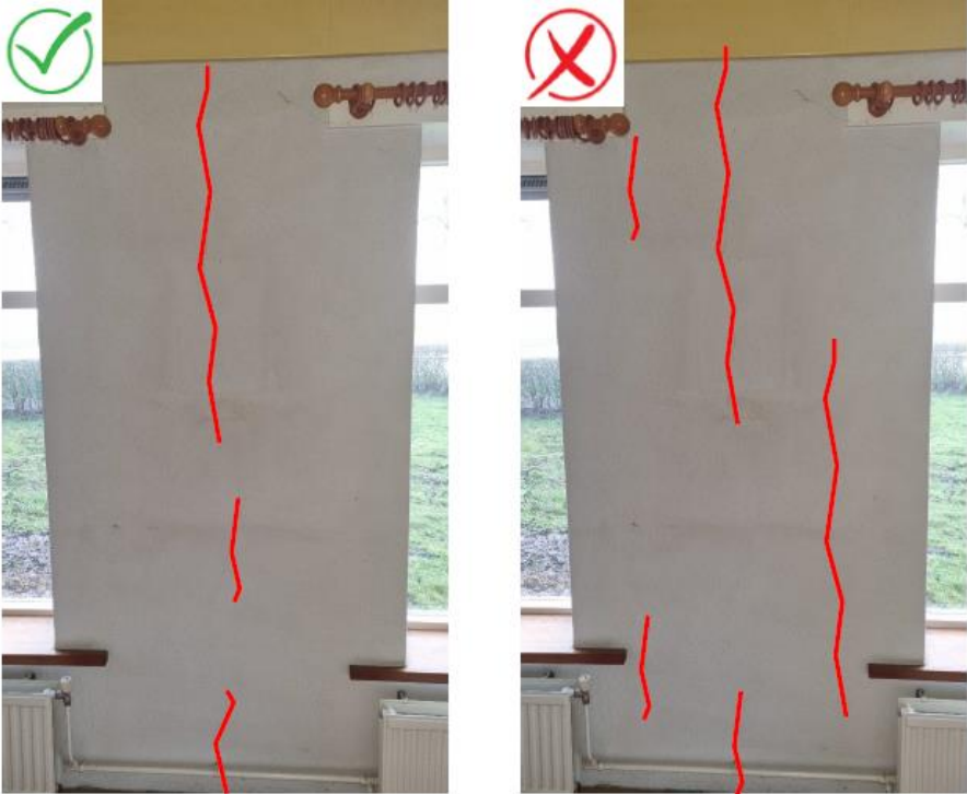
Afb. 6: Voorbeeld marking meerdere scheuren geclusterd in de wand. Op de linker afbeelding mogen de schades geclusterd worden, omdat ze aan alle bovengenoemde eisen voldoen. Op de rechter afbeelding lopen scheuren niet in het verlengde van elkaar. Deze schades moeten apart worden opgenomen. Daarnaast mogen de scheuren op de rechter afbeelding ook niet geclusterd worden, omdat de afstand tussen de scheuren die wel in het verlengde van elkaar zijn groter is dan de helft van de lengte van de kortste scheur.
