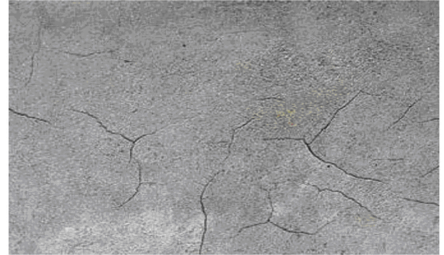
Craquele in stucwerk
